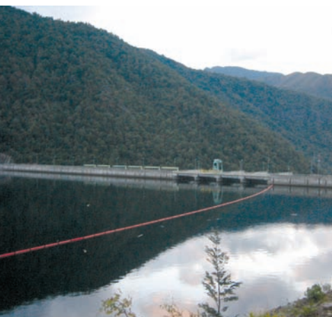
Central hidroeléctrica Pangué, Chile
