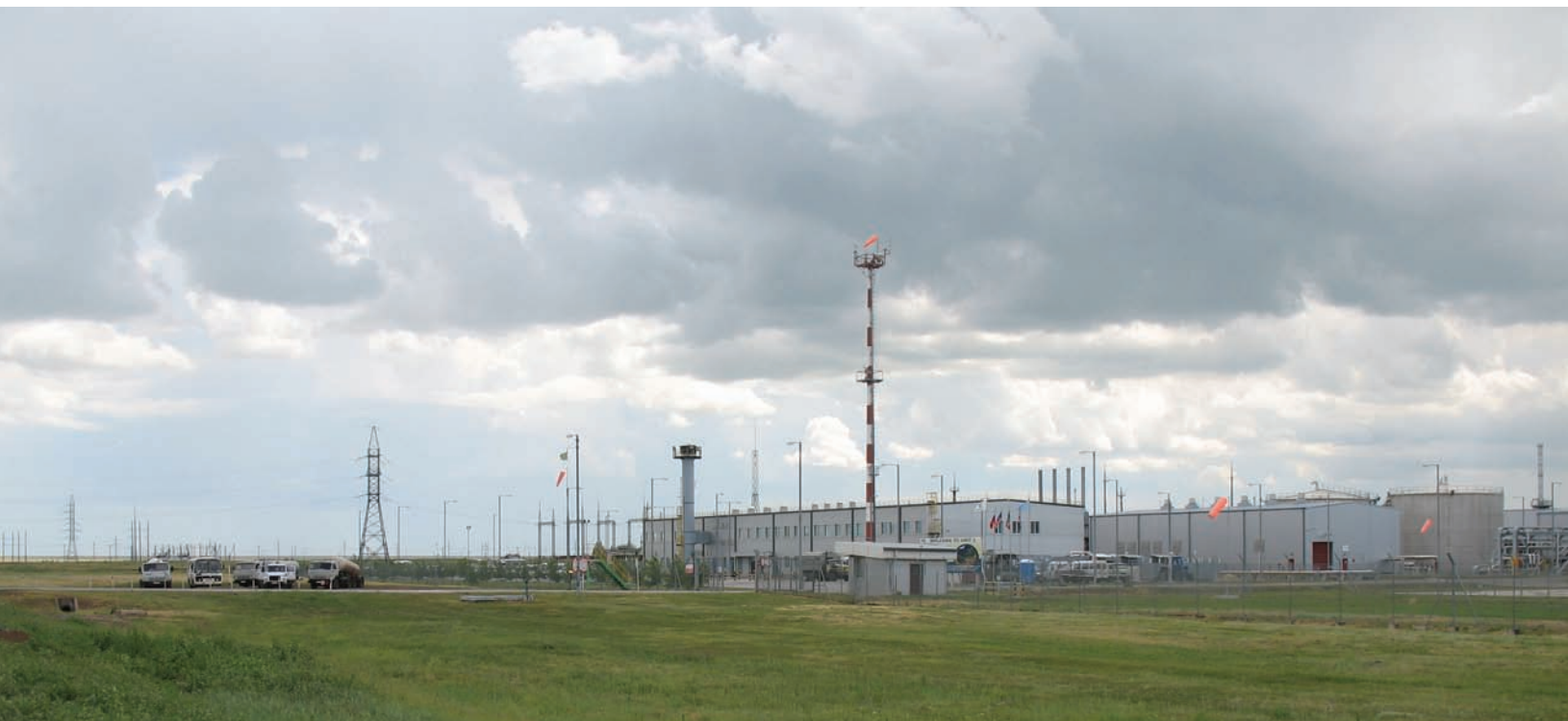
Instalaciones de Lukoil, Kazajstán
