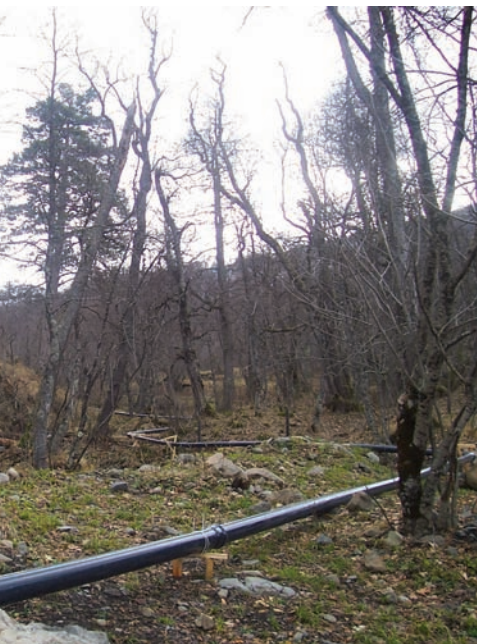
Tubería de agua potable instalada tras el proceso de la CAO, en Tsemi, Georgia
