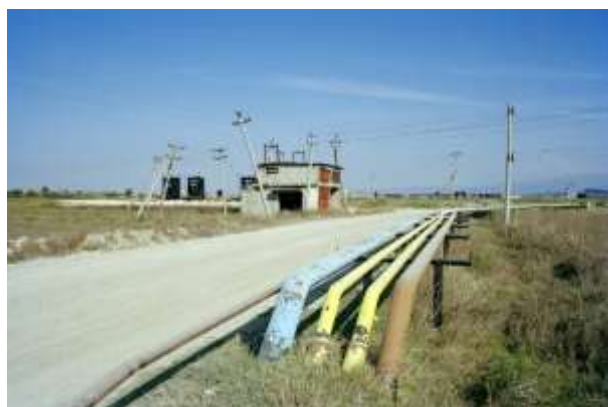
Tubacionet e transportimit të naftës, gazit dhe ujit, të ndërtuar për të ulur trafikun, në zonën qendrore të nxjerrjes në Patos-Marinëz (Foto nga: Felix Davey).
