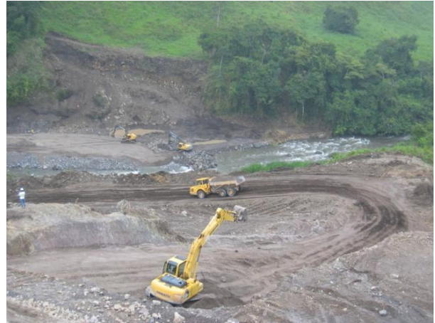
Construcción de la central hidroeléctrica de EISA, Río Chiriquí Viejo, Panamá
